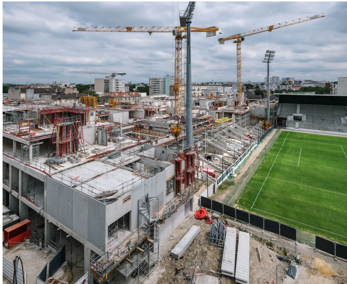
STADE BAUER (Saint-Ouen) Construction de la BAUER BOX
