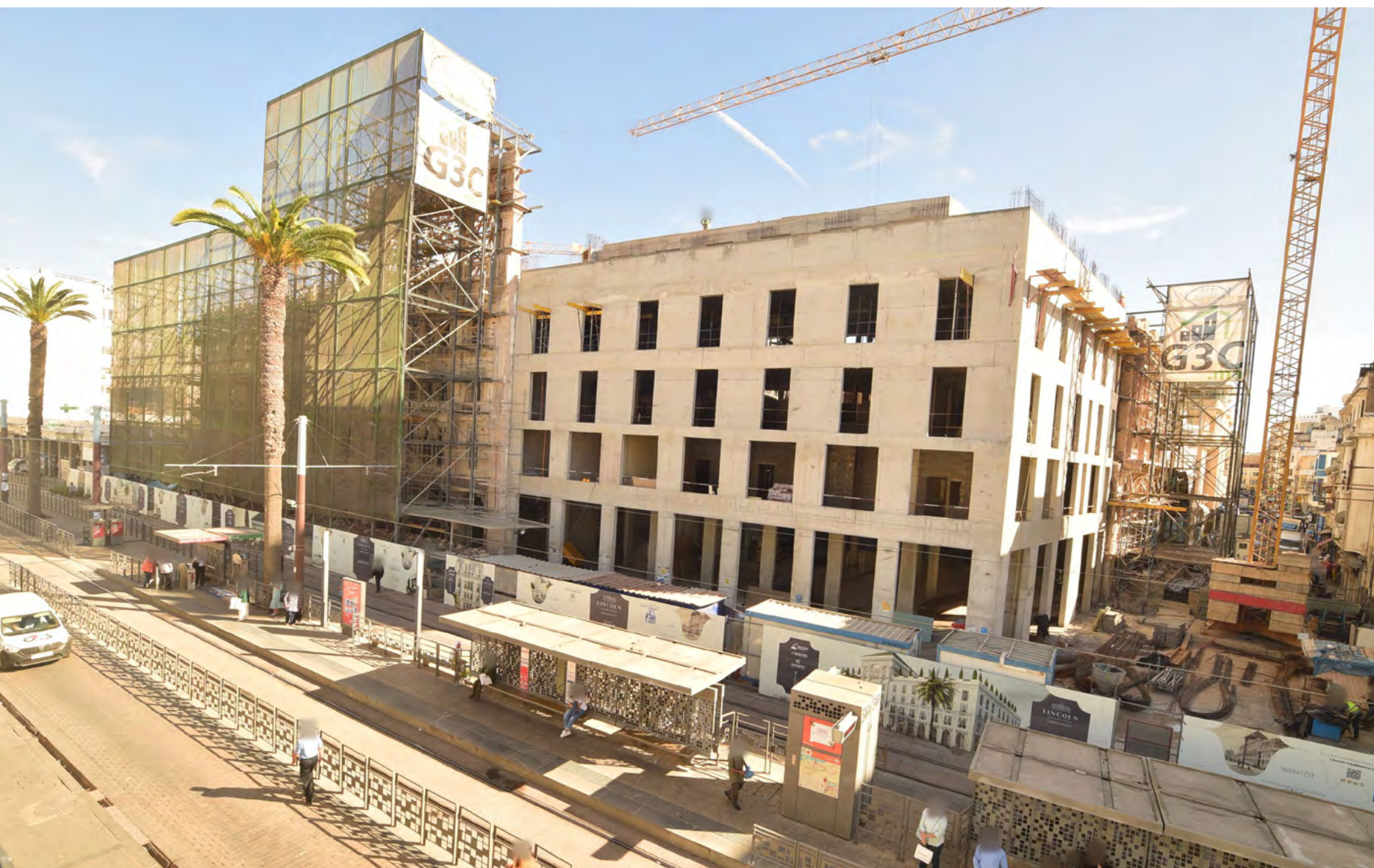
Hôtel Lincoln (Casablanca, Maroc) - Travaux de réhabilitation en cours
